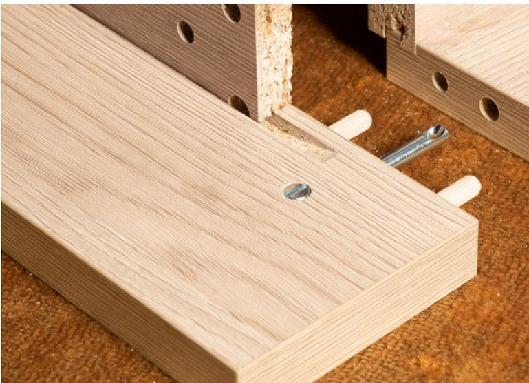
Setze einen Bolzen in das runde Bohrloch ein. Achte darauf, dass der Schlitz möglichst gerade liegt, parallel zur Außenkante. Drücke den Bolzen in die Bohrung hinein. Schraube den Gewindestift von Hand in das Gewinde des Bolzens. Achte darauf, dass das Loch des Gewindestiftes gerade nach oben zeigt.
