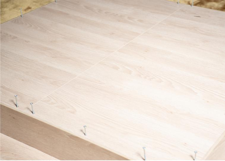
Schraube auch die restlichen Bodenschrauben mit Kreuzschlitz ein. Es können einige Schrauben übrig bleiben bei kleineren Tischgrößen.
